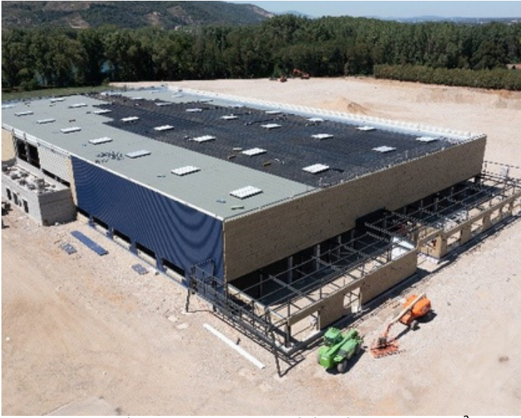
Construction d'une usine automobile de 12 000 m 2 pour AIXAM MEGA
