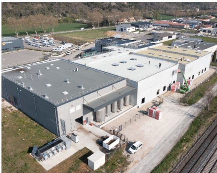
Construction d'un bâtiment industriel, comprenant bureaux, stockage et process, de 7 000 m 2
