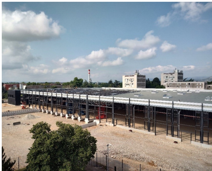
Construction d'un centre de tri postal de 12 000 m 2 pour LA POSTE GROUPE
