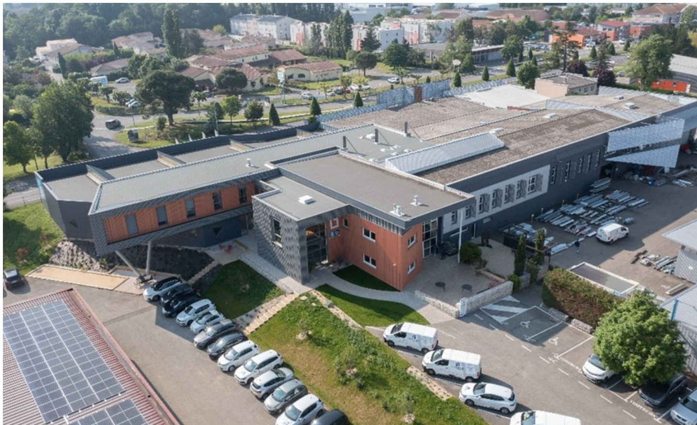
Siège de Bonhomme Bâtiment – 1 200 m 2 de bureaux & 9 500 m 2 d'ateliers
